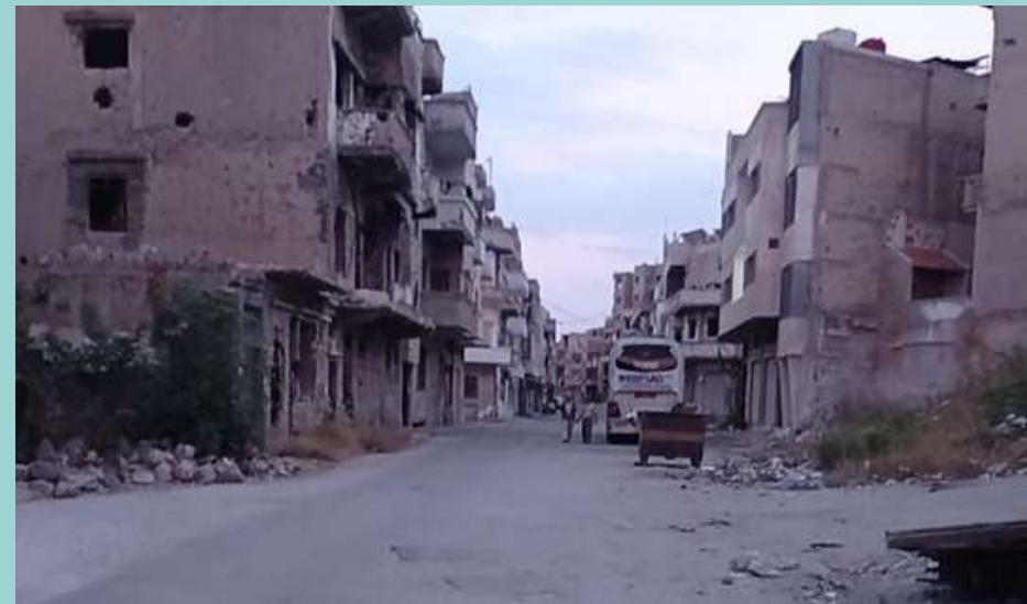
La reconstruction de maisons dans le vieux Homs, octobre 2023
