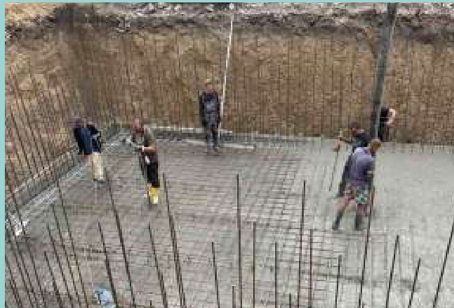
Construction d'un bunker de protection, août 2024
